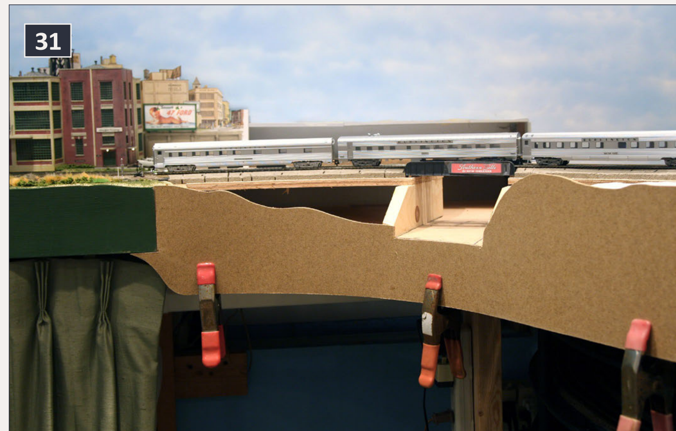
31: Installing the fascia.
